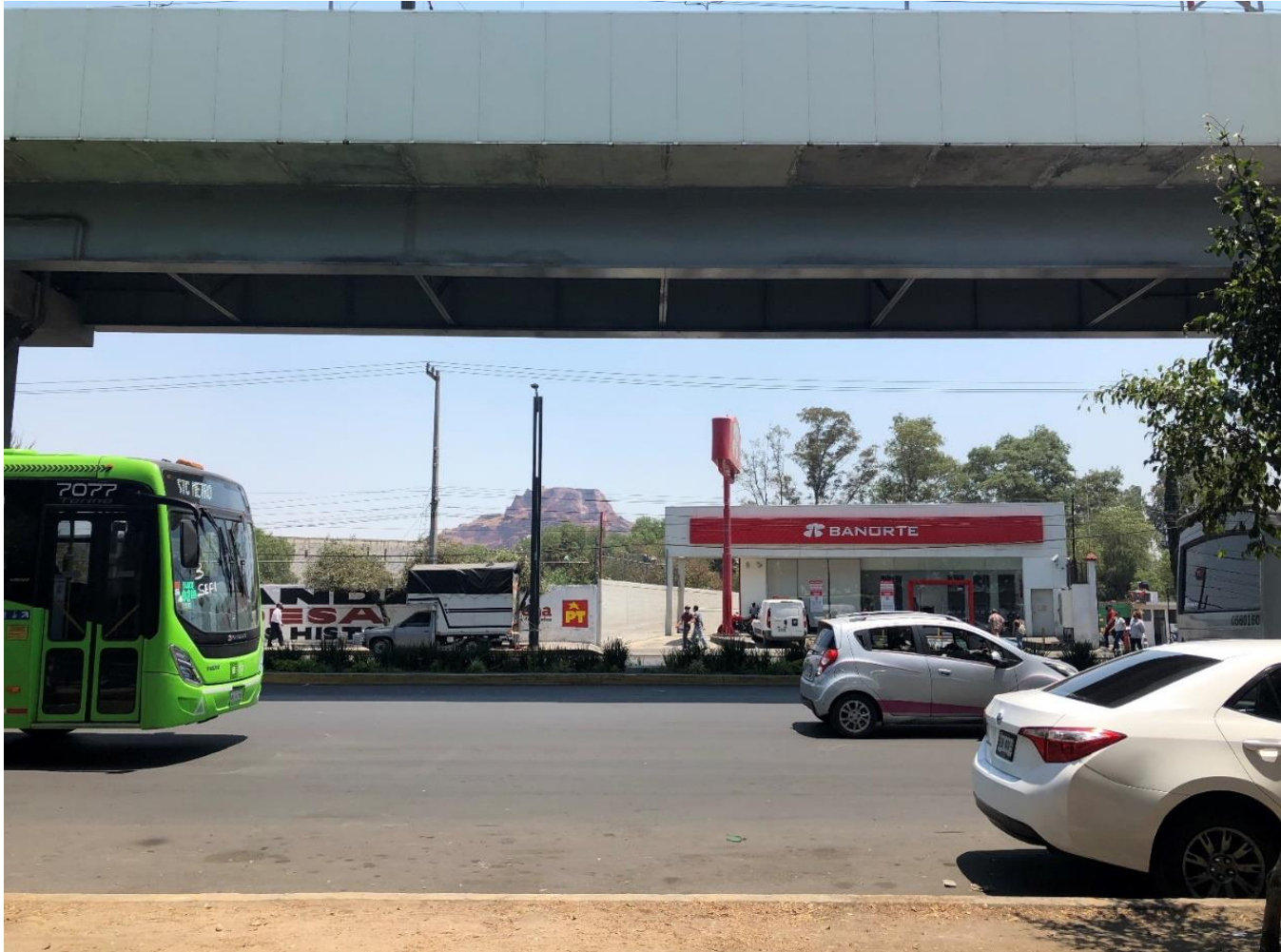
Tramo: Olivos-Nopalera. Cruja entre columna 10 – columna 11
