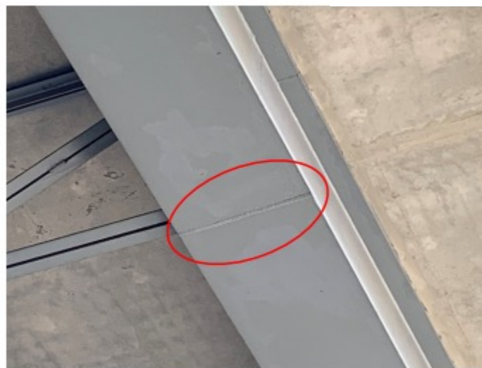
Empalmes de vigas metálicas longitudinales en el centro de la trabe
