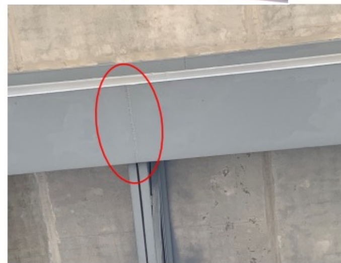
Empalmes de vigas metálicas longitudinales en el centro de la trabe
