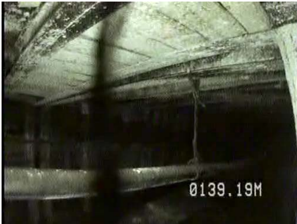
Figura 4.18 El pozo de degasificación 7 muestra la estructura rehabilitada aún intacta
