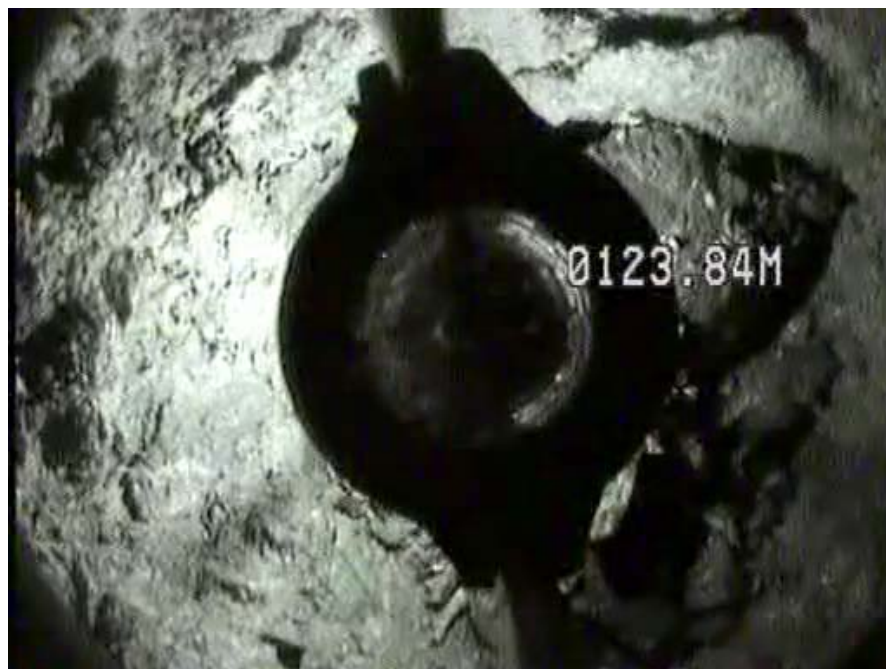
Figura 4.22 C-6 obstruido a 124 metros
