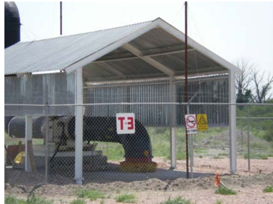
Figura 3.2 Ventilador del barreno de purga.
