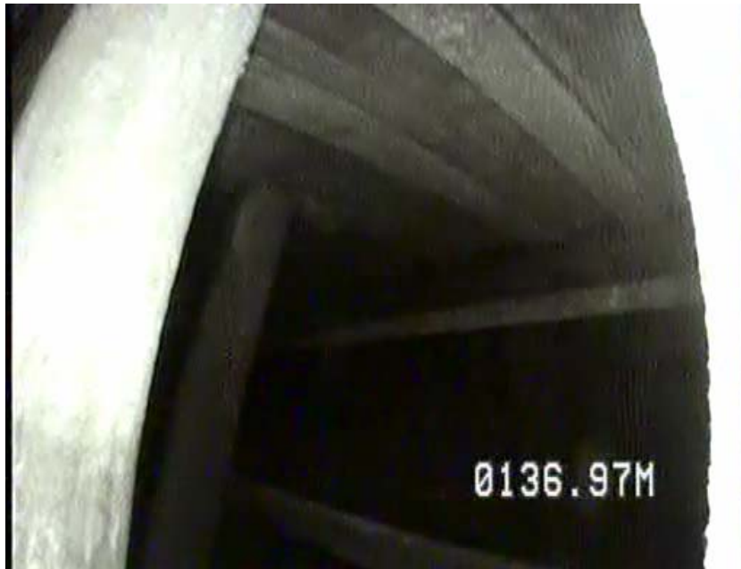
La Figura 4.17 muestra la estructura de soporte del pozo de degasificación 5 intacta.
