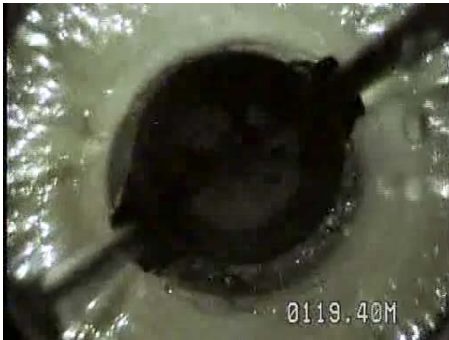
Figura 4.8b. Bloqueo del C-10 visto a 119.4 metros.
