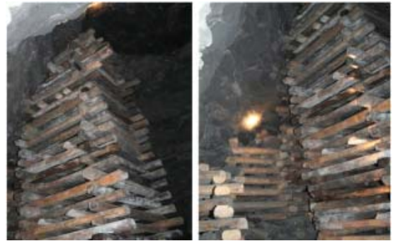
Figura 2.5 Revestimiento para dar soporte al área que presentaba caído.
