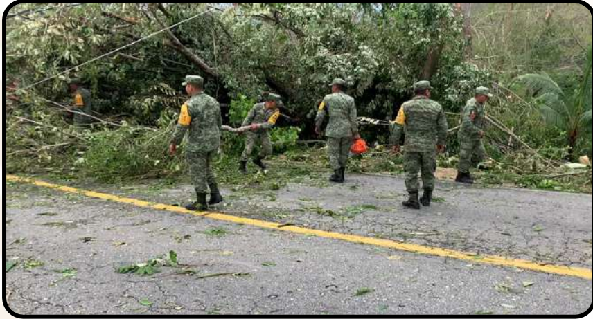
Afectaciones por fuertes lluvias
