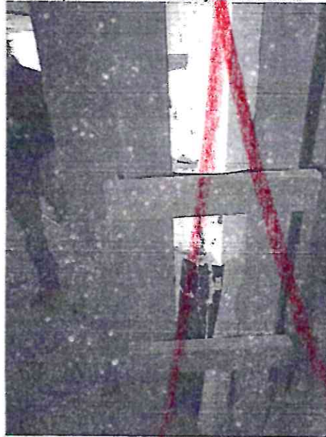
Columnas dañadas (fracturas diagonales, desconchamiento y exposición del acero de refuerzo) con apuntalamientos metálicos precarios de baja calidad en materiales y calidad técnica.
