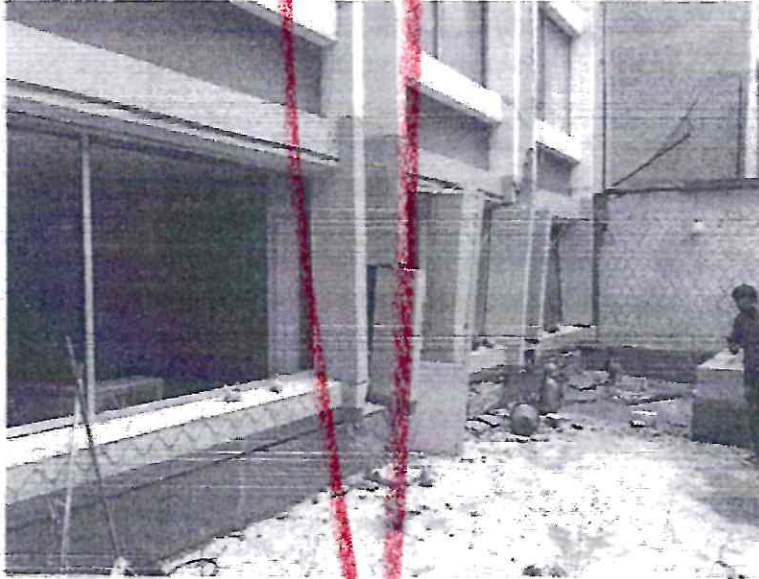
Vista del exterior de un pozo de luz, donde se aprecia el desprendimiento de elementos arquitectónicos.
